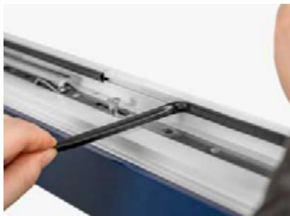
Entnahme der Flügeldichtung
