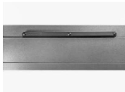
Montierter Lüfter bei einem Aluminiumfenster
